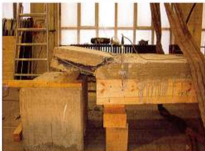
Bild 18. Konsolle nach Bruch Fig.18. Cantilever after failure
