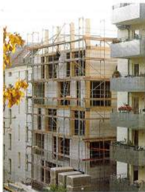
Bild 4. Holz-Skelett-Konstruktion während der Bauausführung Fig.4. Timber structure during construction
