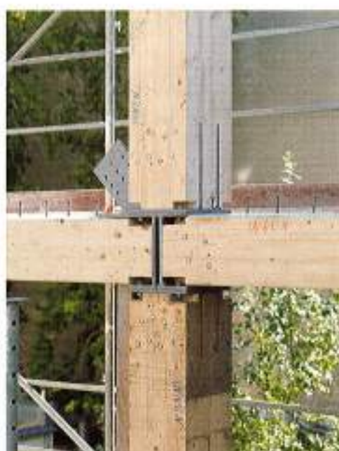
Bild 7. Knotendetail während der Bauausführung Fig. 7. Connection detail during construction
